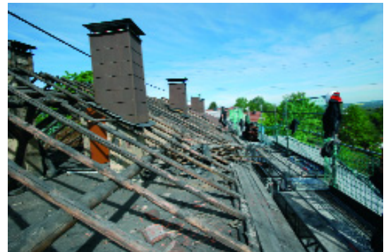
Dachgebälk-Erneuerung am Schaumbergring 1-7
