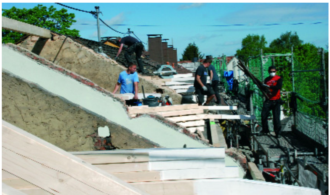
Dachgebälk-Erneuerung am Schaumbergring 1-7
